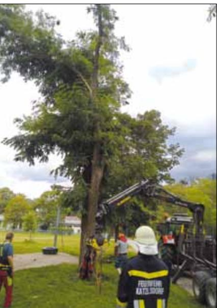
Der Wurzelstock eines Baumes konnten aufgrund des starken Sturmes und der durchnässten Erde das Gewicht des Baumes nicht mehr halten, der dadurch auf eine Stromfreileitung stürzte und diese abzureißen drohte. Mittels Seilwinde wurde der Baum gesichert und in weiterer Folge aus dem Gefahrenbereich gezogen und entfernt.
